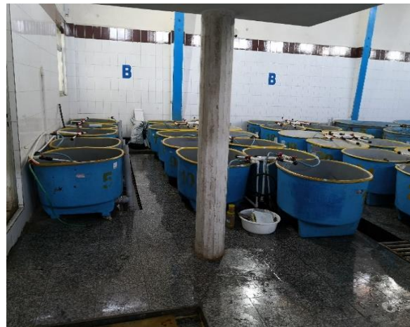
شکل ۱-۲- مخازن فایبرگلاس ۵۰۰ لیتری پرورش لارو
